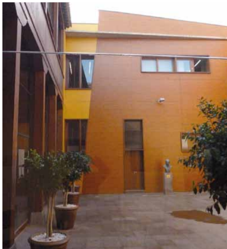
Reforma pastiche en el interior de la sede de la Económica, inmueble protegido del siglo XVIII.
