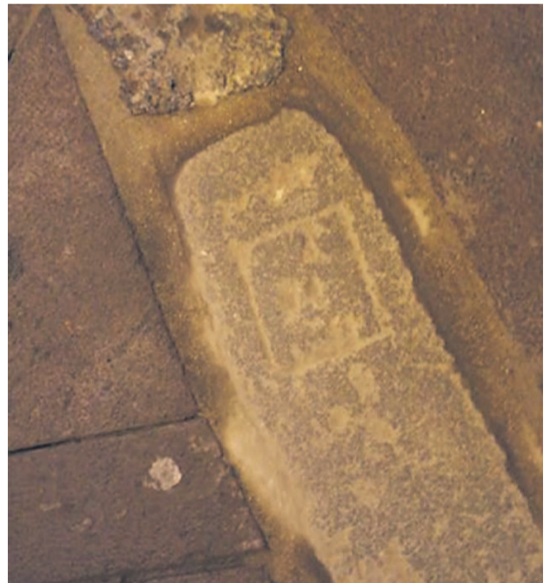
Punto topográfico grabado sobre un petril de basalto cerca del estanque de los patos. / Foto: Rafael González.
